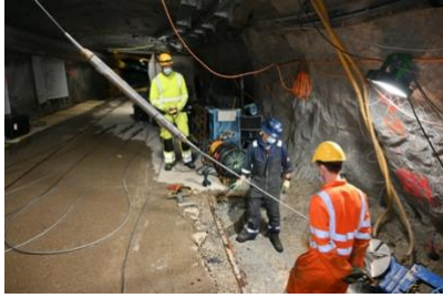
Installation einer Seismometerkette im Bohrloch ST1 zur Überwachung der Stimulationen im Bohrloch ST2, im Bedretto-Labor der ETH Zürich. Die Arbeiten wurden unter der Leitung von Geo-Energie Suisse durchgeführt. © Geo-Energie Suisse
