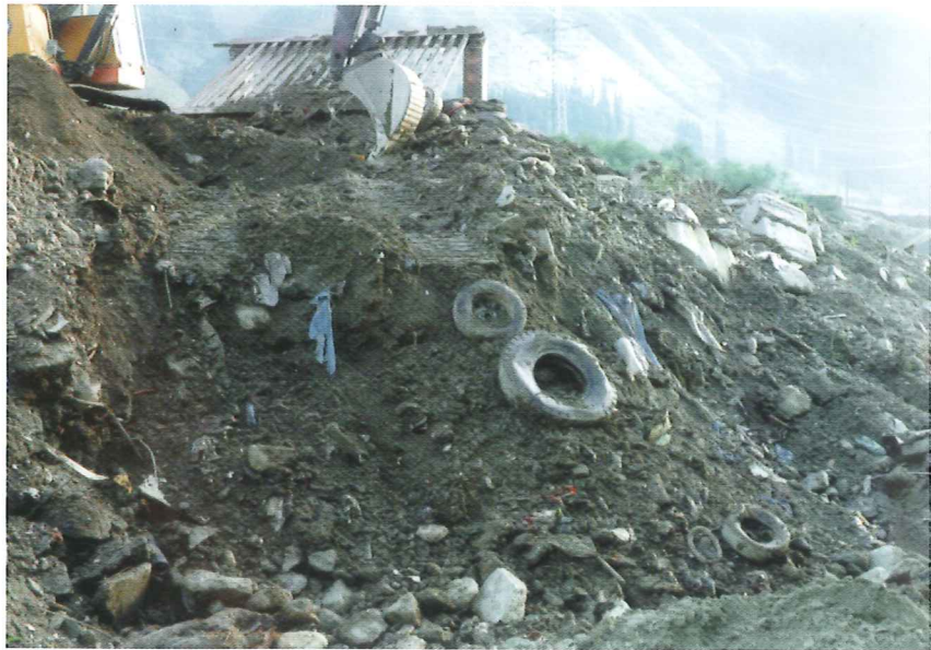
Abb. 2 Aushubarbeit mit Bagger, kaum Homogenbereiche vorhanden, teils Handauslese von sperrigem Material notwendig
