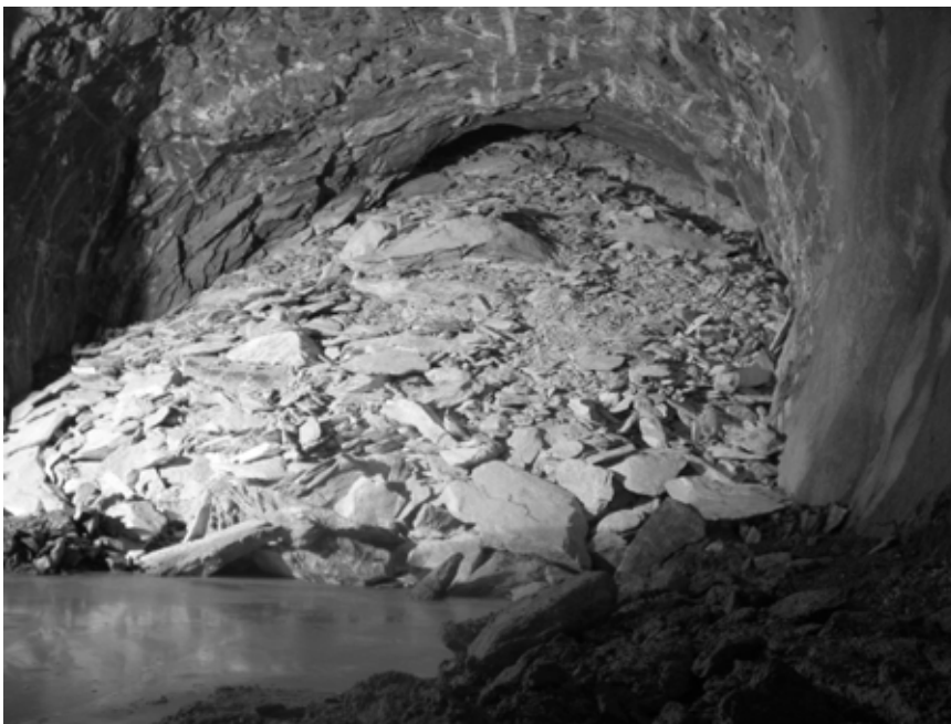
Figur 7. Südliches Tavetscher Zwischenmassiv, Multifunktionsstelle (Seitenstollen Nord): Niederbruch von Talkschiefern aus der Ortsbrust und der Firste.
