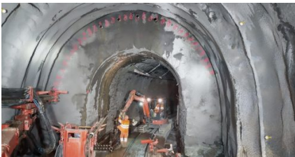
Bild 1: Ausführung von Rohrschirmbohrungen im Übergangsbereich Fels - Lockergestein
