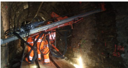
Bild 2: Durchführung von Gewölbekontrollbohrungen im Rahmen der Ausführung
