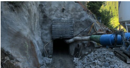
Voreinschnitt am Nordportal des Rohrstollens für die Druckleitung.
