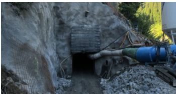
Voreinschnitt am Nordportal des Rohrstillens für die Druckleitung.
