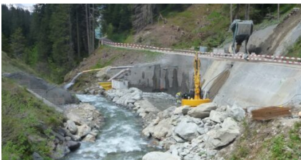
Übersicht Fassung Lumbreinerbrücke mit den beiden talseitigen Voreinschnitten für das Fassungsbauwerk.
