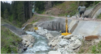
Übersicht Fassung Lumbreinerbrücke mit den beiden talseitigen Voreinschnitten für das Fassungsbauwerk.
