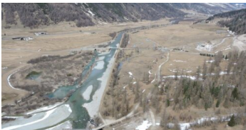
Revitalisierung im Endzustand.
