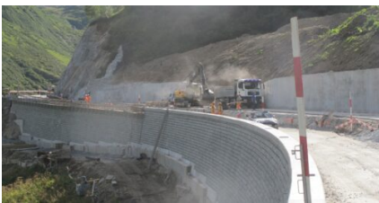
Strassenkorrektur im Endausbau.
