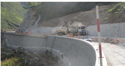
Strassenkorrektur im Endausbau.
