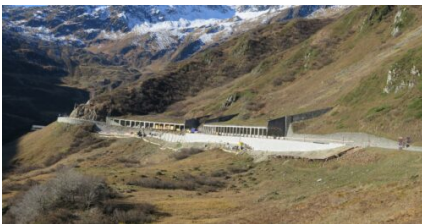
Ansicht der Lawinengalerie vor Bauarbeiten.
