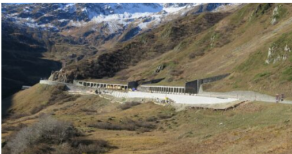
Ansicht der Lawingalerie vor Bauarbeiten.
