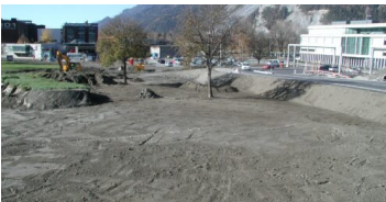
Flächen der Bodenzwischenlager werden mit dem Grubber gelockert.
