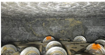
Geologische Aufnahme während Meisselkontrolle an der Ortsbrust des Druckschachtes.
