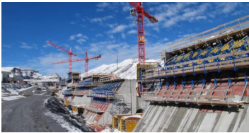
Staumauer Muttsee in der Bauphase Sommer 2013.
