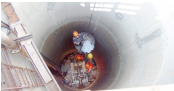
Brunnensenkschacht, Erstellung des horizontalen Filtergestänges.
