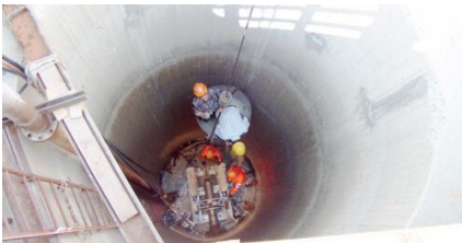
Brunnensenkschacht, Erstellung des horizontalen Filtergestänges.
