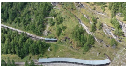
Bild 3: Drohenaufnahme als Grundlage für Gefährdungsanalyse und Risikobeurteilung Naturgefahren
