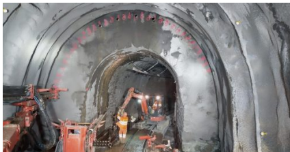
Bild 1: Ausführung von Rohrschirmbohrungen im Übergangsbereich Fels - Lockergestein
