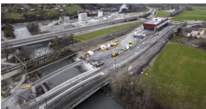
Fertiggestellte Landquartbrücke und Gebäude ISP (@RhB)
