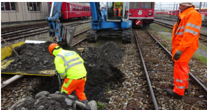
Sondagen im Gleisbereich zur Klärung der oberflächennahen Ausbaus des natürlichen Untergrundes und des Gleisunterbaus
