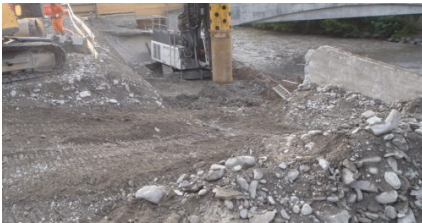
Erstellung von Spezialfundationen am Ufer der Landquart für das Widerlager der Landquartbrücke
